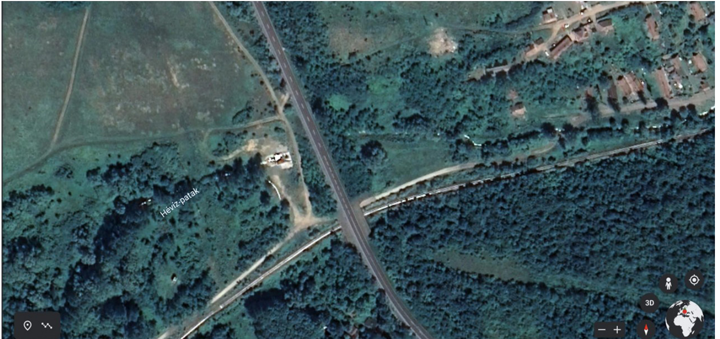
27. ábra: A Google Earth térképen a Hévíz-patakot keresztező 2. sz. főút egy nem megfelelően méretezett átvezetőcsatornával
