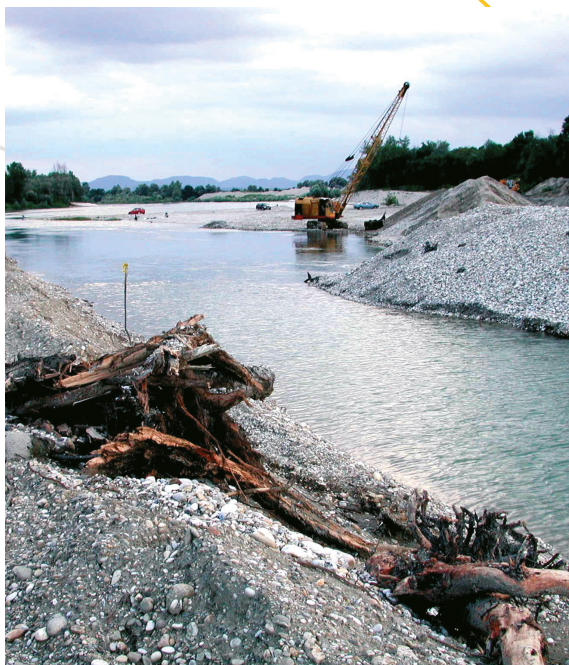
Slika 17. Izkopavanje prodnatih naplavin iz rečne struge
