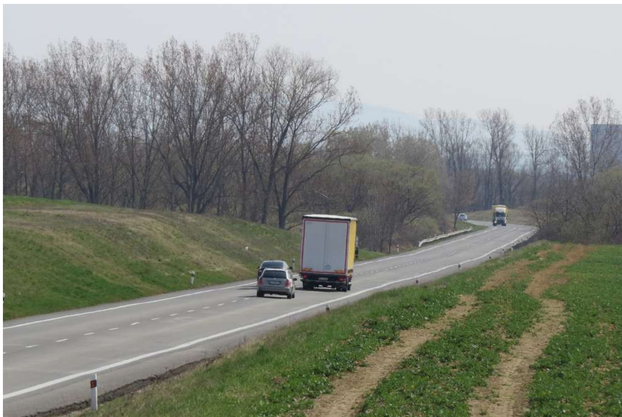
Obr. 61: Pohľad na biokoridor Čečejevce popri ceste I. triedy I/16.
