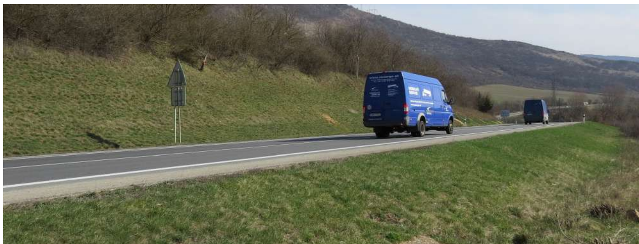
Obr. 54: Pohľad na biokoridor Zádiel popri ceste I. triedy I/16.
