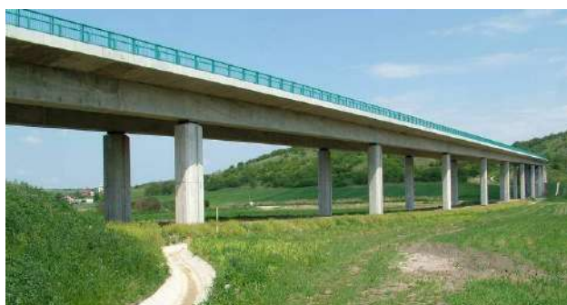
Obr. 22: Viadukt pri obci Ožďany.
