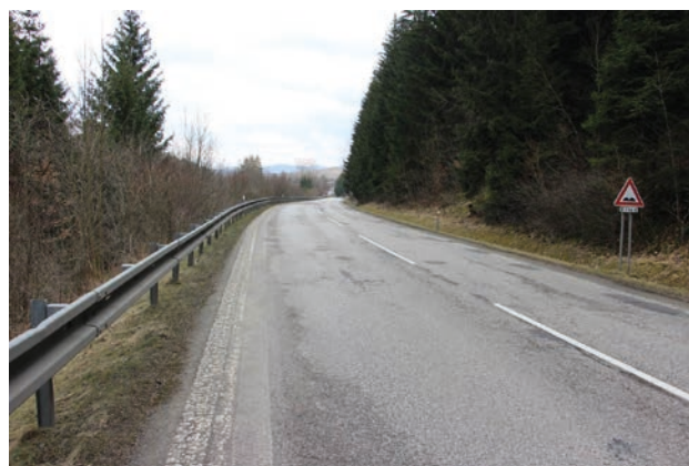
Obr. 72: Pohľad na biokoridor Strelenka a cestu I/49.
