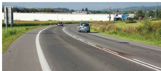
Obr. 51: Pohľad na cestu prvej triedy I/18 v koridore Turany 2.
