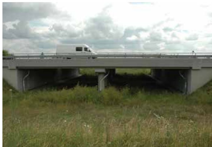
Рис. 75. Зона підземного переходу. Міст прокладений в долині. Літній сезон. Автор: Zoltán Ilonczai
