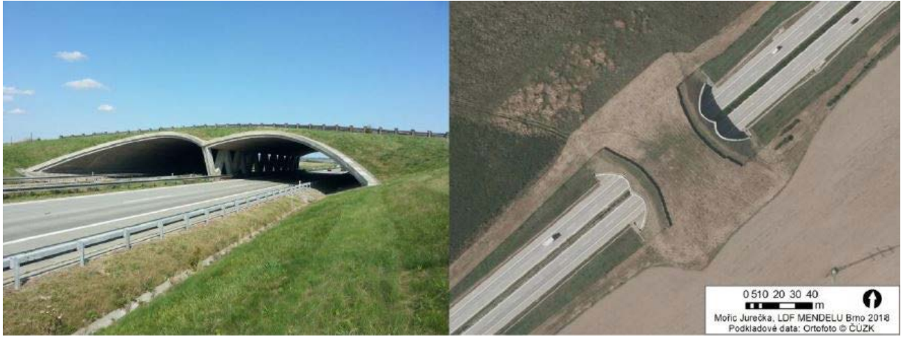
Fig. 42: Locality 11: Overpass Kletné.
