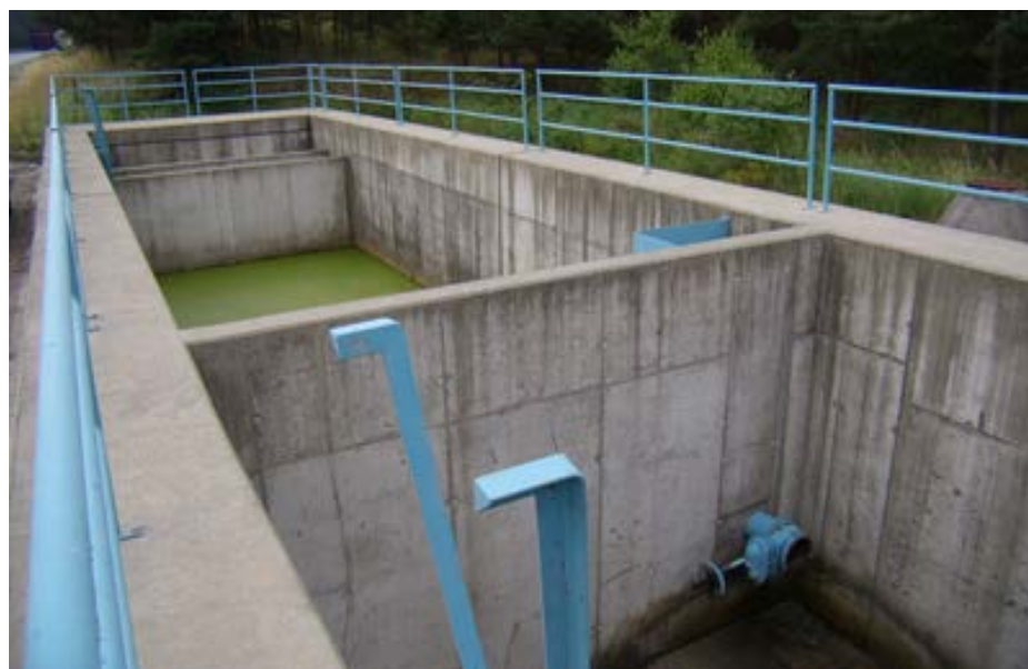
Fig. 50. Rezervoarele de captare a apei de pe autostrăzi sunt uneori parte integrantă din acestea. Ele pot deveni adesea capcane pentru animale. Acest rezervor este echipat cu o balustradă, dar cu toate acestea, în interiorul lui a fost găsit un câprior și mai multe alte animale mici înecate. Prin urmare, este necesar ca astfel de rezervoare să se proiecteze cu capac sau într-un mod care să permită animalelor care cad în interior, să se salveze. (Foto: Petr Anděl)
