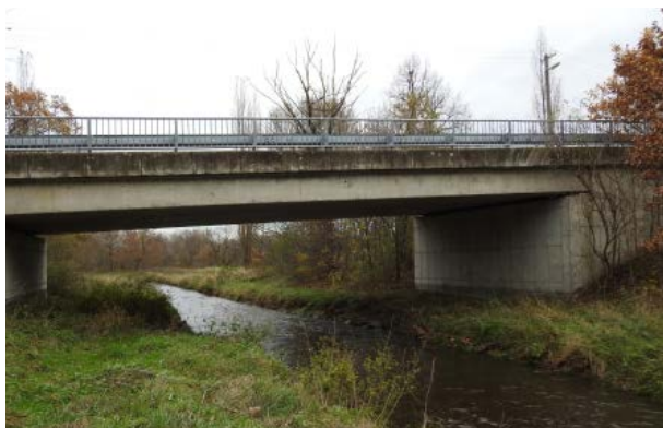
Fig. 57. Viaductele sunt, de obicei, opțiuni mai bune pentru a traversa văile decât rambleurile, deoarece acestea permit libera circulație a animalelor și mențin parțial și conectivitatea habitatelor. Viaductul Aciliu pe autostrada A1 din România. (Foto: Ivo Dostál)
