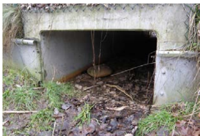
Fig. 106. Canalul rectangular este o soluție bună pentru amfibieni, reptile și mamifere până la mărimea vulpii sau a viezurelui. (Foto: Lukáš Poledník)
