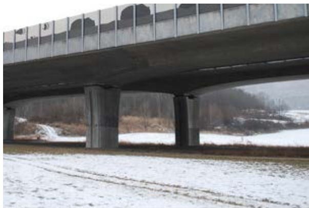
Fig. 99. Subtraversări speciale pentru mamiferele mari sunt construite în locuri în care o autostradă intersectează un coridor de migrație. D1, Bělôtín, Republica Cehă. (Foto: Martin Strnad)
