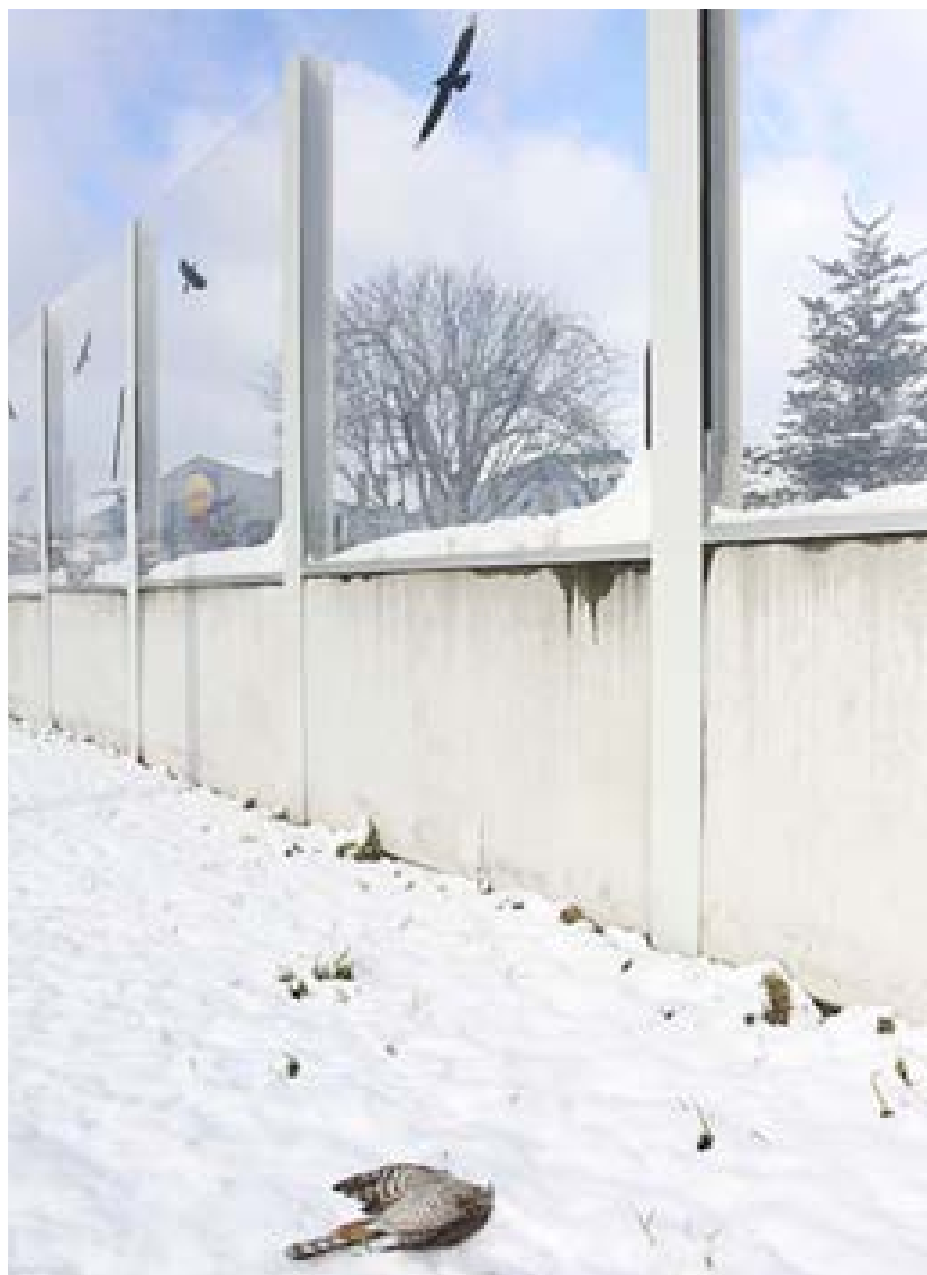
Fig. 25. Pereții transparenți de-a lungul drumurilor din orașe sunt adesea cauza mortalității păsărilor. Trebuie aplicate soluții care să permită păsărilor să observe suficient de devreme posibilele obstacole. (Foto: Václav Hlaváč)
