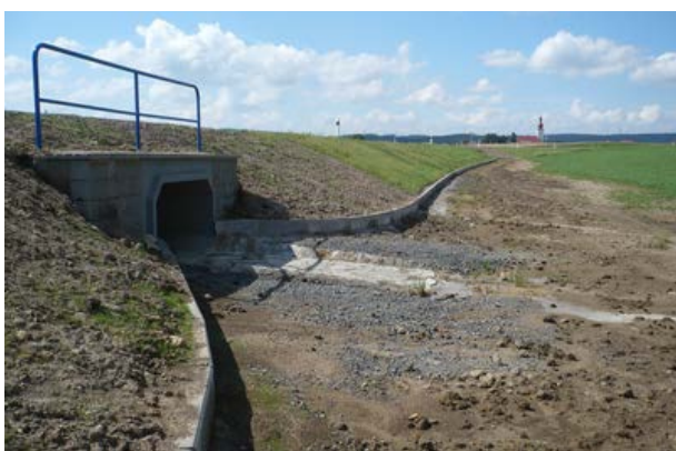
Fig. 119. Barierele permanente sunt construite cu scopul de a ghida amfibienii către un pasaj potrivit. Ele sunt întotdeauna construite pe ambele părți ale infrastructurii. (Foto: Jaromír Maštera)
