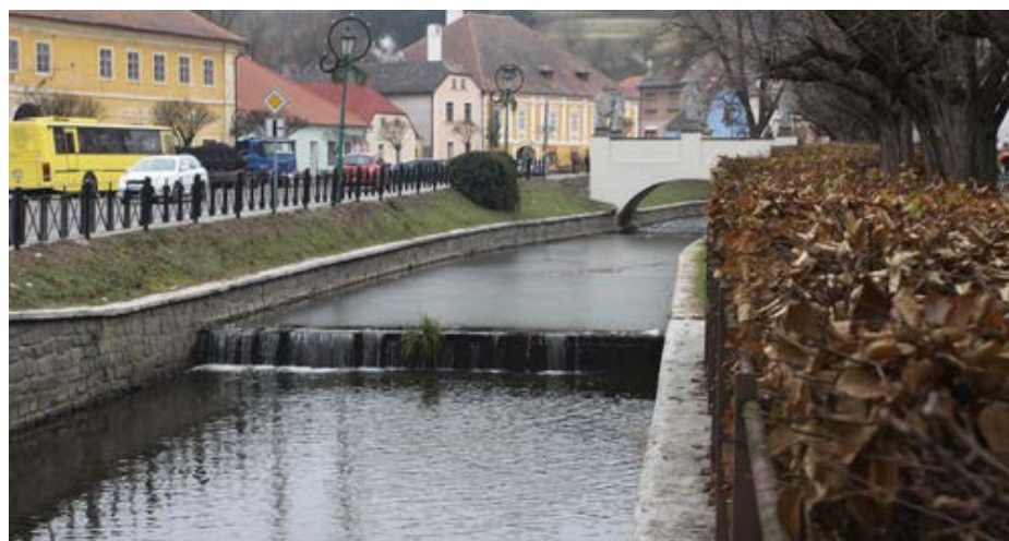
Fig. 79. Stăvilarul în combinație cu pereți verticali de pe ambele părți ale unui curs de apă într-un oraș, fortează animale precum vidra sau castorul să ocolească astfel de structuri, cu traversarea drumurilor adiacente. (Foto: Václav Hlaváč)
