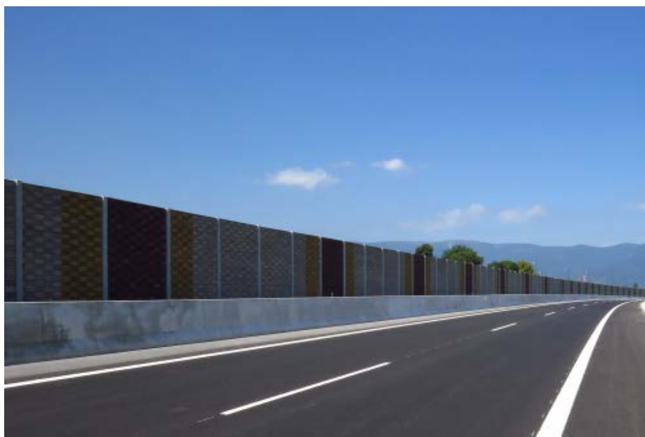
Fig. 48. Un perete de protecție elimină efectul de perturbare sonoră și vizuală, dar mărește efectul de barieră. (Foto:Tomáš Flajs)
