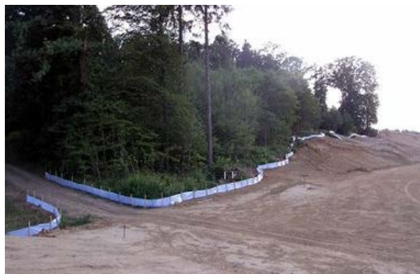
Fig.118. Barierele temporare sunt folosite pentru a împiedica pătrunderea amfibienilor pe șantier. În astfel de cazuri, animalele trebuie să fie îndreptate către un pasaj adecvat sau trebuie să fie capturate și transferate în mediul sigur. (Foto: Naturaservis, Ltd.)
