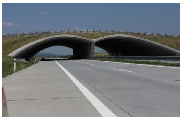
Fig. 56. Dacă este necesar, deplasarea mamiferelor de dimensiuni mari poate fi facilitată și în peisaje plate, prin intermediul unor poduri verzi. Este însă necesar ca dimensiunile acestora să fie suficiente de mari pentru a le asigura funcționalitatea. (Foto: Václav Hlaváč)
