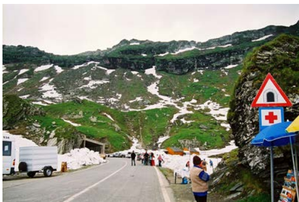
Fig. 38. Pe lângă trafic, activitățile umane de-a lungul drumurilor măresc impactul asupra ecosistemelor montane. Conectivitatea ar trebui asigurată întotdeauna de un număr suficient de tuneluri. Transfăgărașan, România. (Foto: Blanka Dovrtělová)
