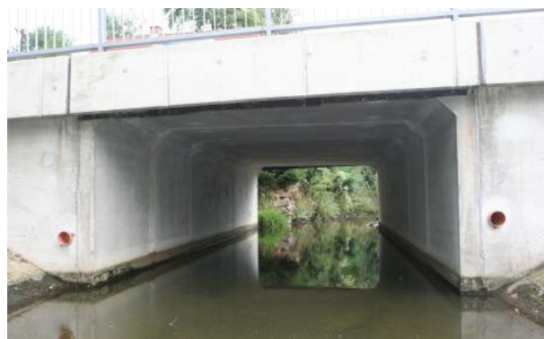
Fig. 47. Un canal fără maluri uscate creează o «barieră psihologică» pentru vidre, deși acestea sunt capabile din punct de vedere fizic să înoate printr-un astfel de canal. Experiența arată că majoritatea vidrelor nu utilizează astfel de traversări, folosind în schimb, drumul. (Foto: Václav Hlaváč)
