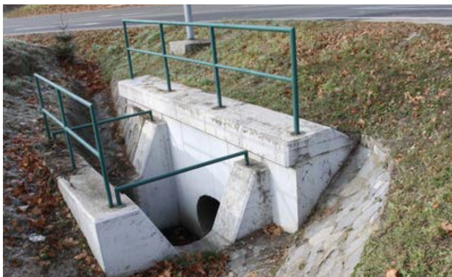
Fig. 73. Prezența rezervoarelor la intrare sau la ieșire împiedică amfibienii să folosească un astfel de canal pentru deplasare. Astfel de soluții pot crea, în plus, capcane fatale în care mor foarte mulți amfibieni. (Foto: Václav Hlaváč)
