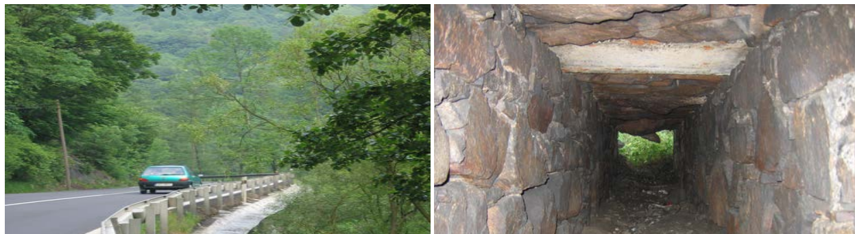
Fig.74. Mortalitatea Șarpelui lui Esculap poate fi prevenită prin instalarea unor bariere speciale de-a lungul infrastructurii de transport pe care șerpii nu o pot depăși. Barierele trebuie să ghideze animalele către canale suficient de mari, unde pot traversa în siguranță drumul. E442 / R13 lângă Strážnad Ohři, Republica Cehă. (Foto: Zamenis, z.s.)
