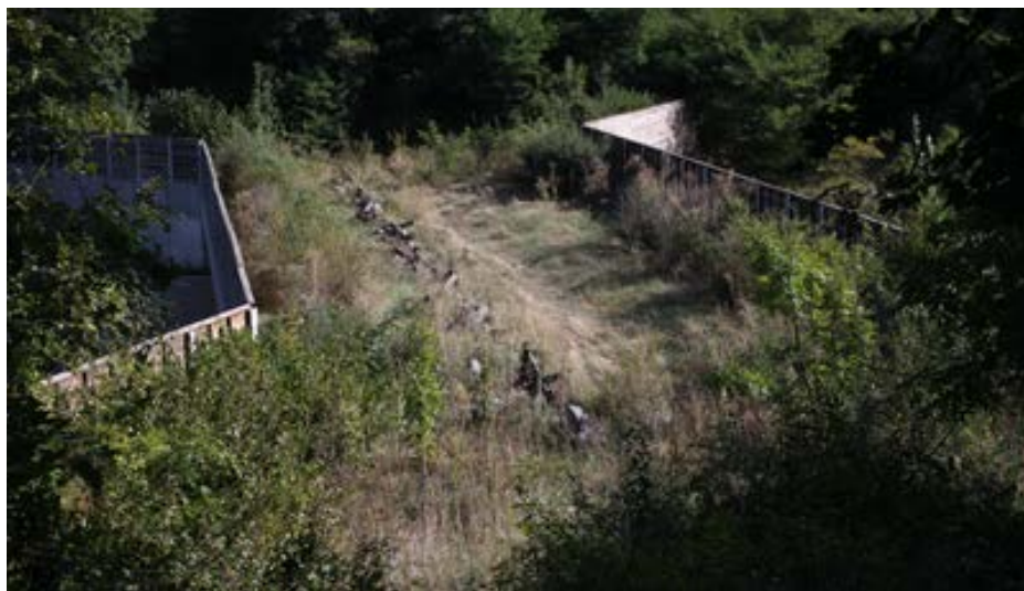
Fig. 88. Podurile verzi trebuie să aibă un management adecvat. Lemnul mort și plantarea de arbuști pe lateralele podului au fost folosite în timpul construcției și succesiunea ulterioară a condus la o bună legătură naturală cu mediul înconjurător. Franța. (Foto: Václav Hlaváč)
