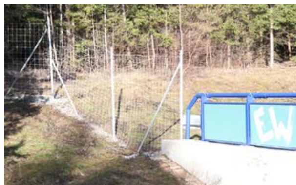
Fig. 90. Împrejmuirea continuă conectată cu peretele de protecție (balustradă) conduce animalele care urmează gardurile aflate de-a lungul autostrăzii până la intrarea pe un pod verde. D1, Republica Cehă. (Foto: Václav Hlaváč)
