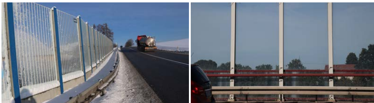
Fig.121. Dungile verticale sau geamul armat reprezintă o măsură de protecție eficientă pentru păsări, și în același timp, reprezintă și o soluție acceptabilă în ceea ce privește arhitectura. (Foto: Václav Hlaváč)
