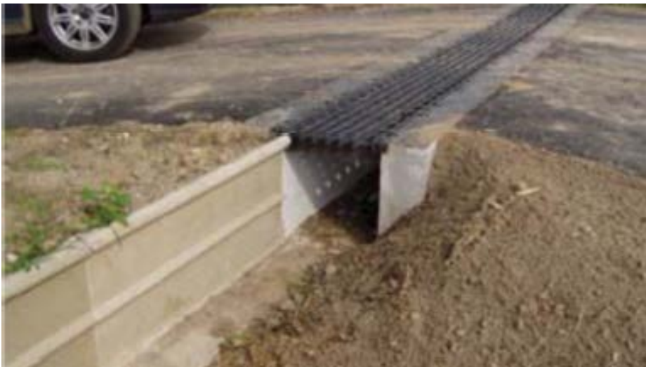
Fig.111. Tunelurile pentru amfibieni sunt o soluție bună pentru traversarea drumurilor înguste. Pentru funcționarea corespunzătoare o condiție necesară este întotdeauna construirea de bariere de ghidare care împiedică pătrunderea amfibienilor pe drum și asigură ghidarea acestora către pasaje, în siguranță. (Foto: Natu-raservis, Ltd.)
