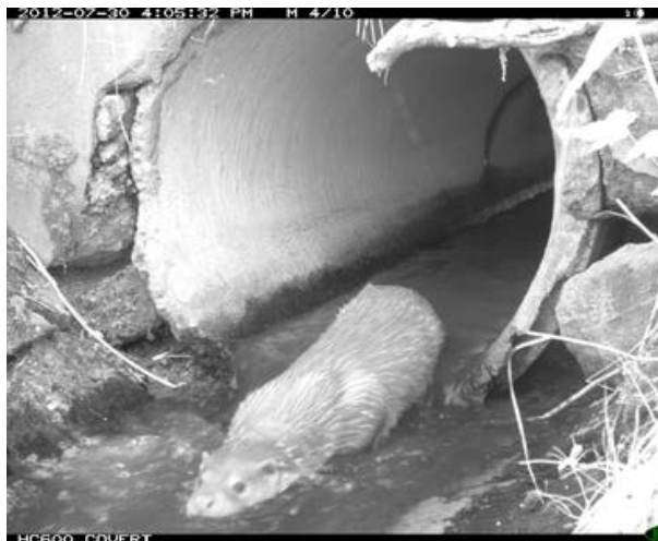
Fig. 36. Canalele cu un design potrivit pot servi ca pasaje pentru faună pentru multe specii de faună. Forma dreptunghiulară este întotdeauna soluția de preferat. Canalele tubulare nu sunt o soluție optimă, dar vidrele sunt capabile să le utilizeze în momente în care debitele sunt mai scăzute. (Foto: Václav Hlaváč)
