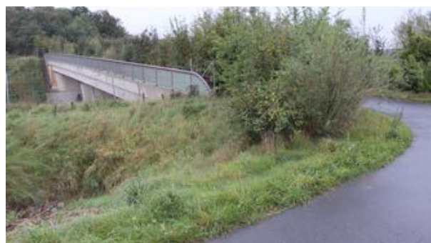
Fig. 81. Benzile de arbuști de pe ambele părți ale pasajului permite conectarea la habitatul forestier din vecinătatea unei autostrăzi pentru multe specii, inclusiv mamifere arboricole, păsări mici sau lilieci. Acesta reprezintă o măsură accesibilă, cu efect puternic. Dresda, Germania. (Foto: Václav Hlaváč)
