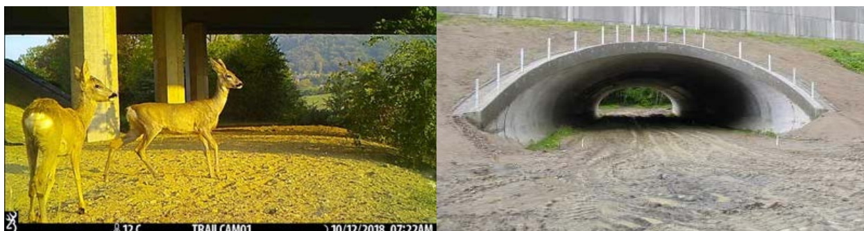
Fig. 100. Comportamentul animalelor în apropierea trecerilor subterane evidențiază faptul că animalele înregistrează zgomotul cauzat de vehiculelor - (a) Prin urmare, în timp ce construim noi poduri, este întotdeauna necesar să alegem o soluție care reduce zgomotul de sub pod. Zgomotul sub pod este cel mai bine eliminat atunci când există un strat de sol între construcția podului și drum / calea ferată. (b) Cu toate acestea, această soluție duce, în condiții comparabile, și la o reducere a dimensiunilor podurilor. (Foto: (a) Friends of the Earth Republica Cehă, (b) Agenția pentru Conservarea Naturii din Republica Cehă)
