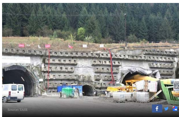
Fig. 62. Construcția tunelurilor forate, autostrada Višňové, Slovacia (Sursă Foto: TASR 18 )
