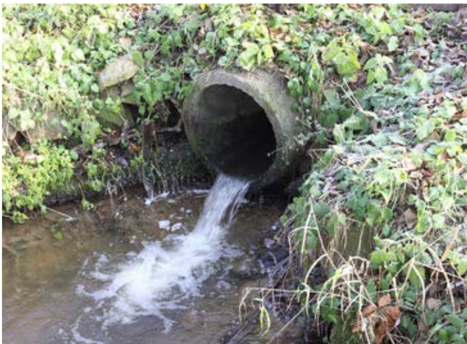
Fig. 70. Canalele de scurgere cilindrice amplasate în albia râului devin bariere pentru migrația peștilor. (Foto: Václav Hlaváč)
