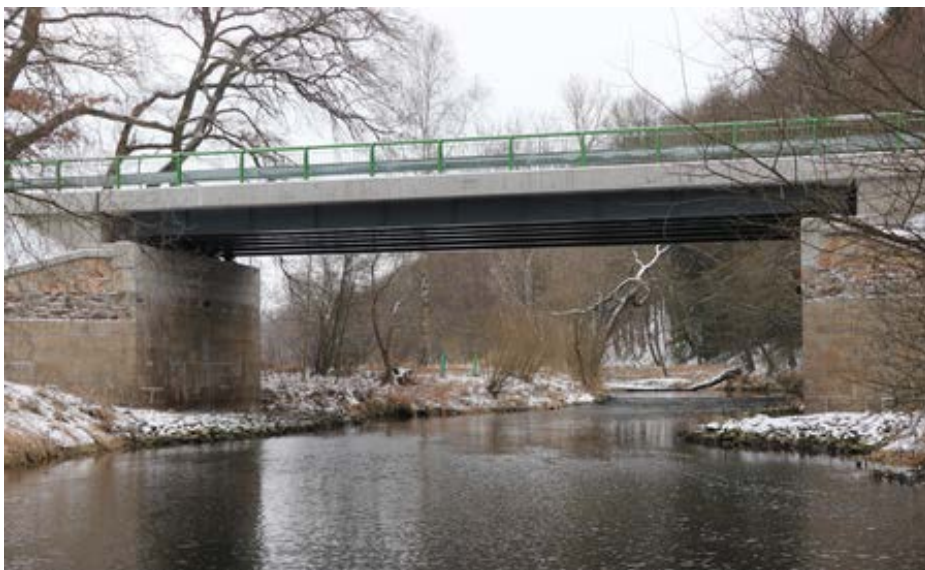
Fig.68. Podurile peste cursurile de apă pot fi adaptate cu ușurință pentru a permite animalelor să le folosească pentru a traversa în siguranță infrastructura. Este necesar să se păstreze malurile naturale conectate cu peisajul înconjurător. (Foto: Václav Hlaváč)
