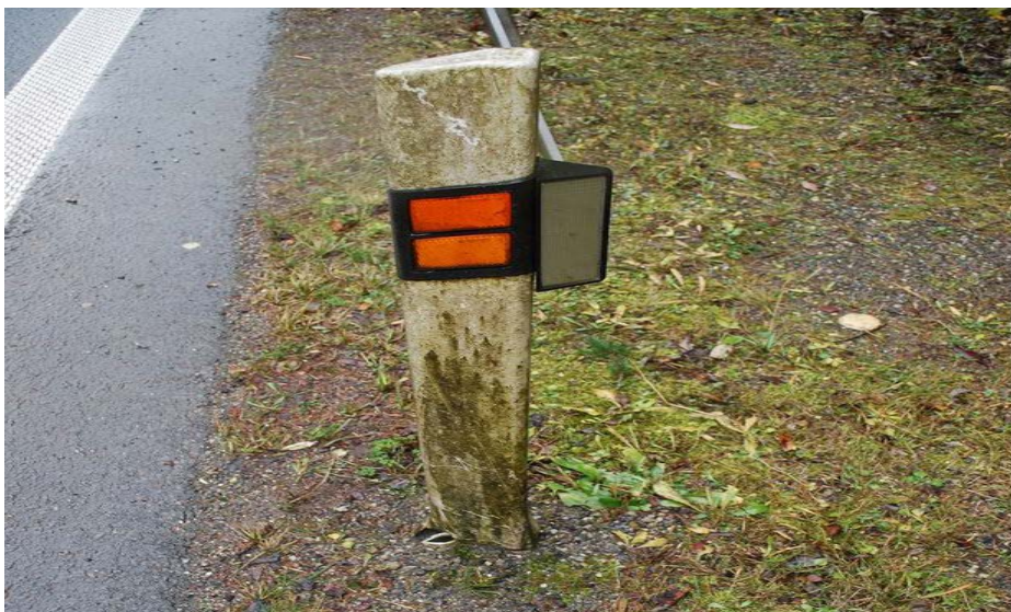
Fig. 140. Mijloace vizuale de descurajare pentru animale, folosind lumina reflectată, amplasate pe stâlpi de pe marginea drumului. Elementul reflectorizant avertizează animalele atunci când se apropie un autoturism. (Foto: Martin Strnad)
