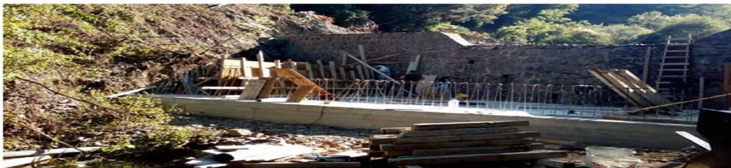
Ремонт на бараж на Марулевска река, ДГС „Благоевград“ Overhaul of the barrage on the Marulevska River, Blagoevgrad SFE
