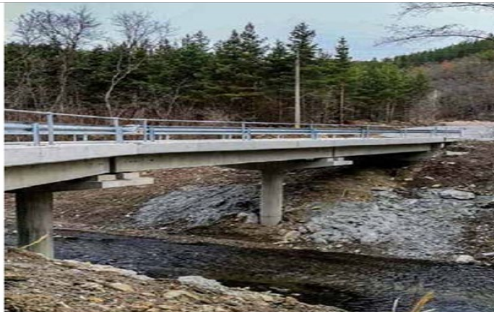
Нов горски път с мост на р. Драговищица New forest road with a bridge on Dragovishtitsa River
