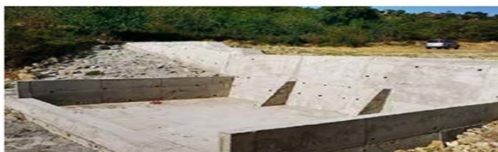
Бараж N° 8 на Рибнишка река в ДГС „Петрич“ – преди и след ремонта Barrage No. 8 on the Ribnitsa River in Petrich SFE, prior and post its overhaul
