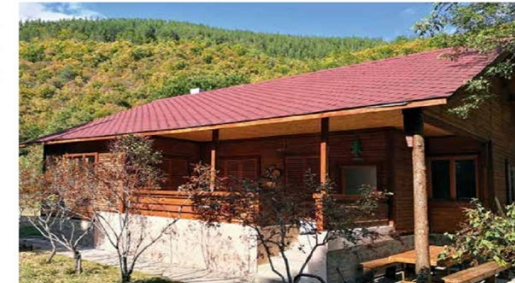
Обновената сграда на разсадник „Долно Уйно“, ДГС „Кюстендил“ The renovated building of Dolno uyno Forest Nursery, Kyustendil SFE
