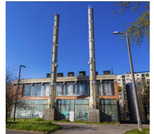
SZETÁV Tarján 8 Boiler room
